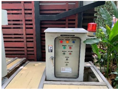
ตู้ควบคุมระบบน้ำดับเพลิง
